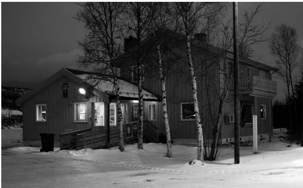
Polmakin tulli joulukuussa 2007. Tulli on toiminut samassa rakennuksessa vuodesta 1970 lähtien. - Tullihallituksen viestintä
