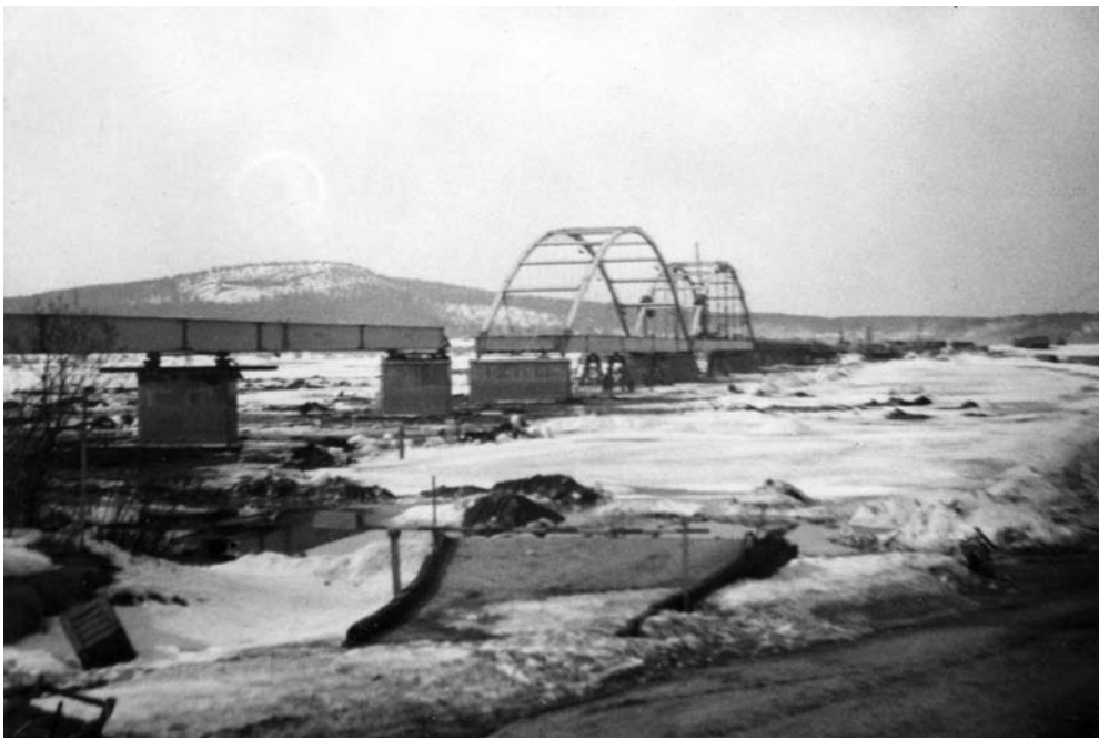
Aavasaksan siltaa rakennettiin keväällä 1965. Etualalla lossi- ja jäätieramppi Suomen puolella. - Sakkeuksen poikien albumi
